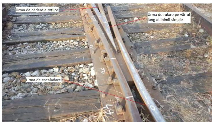
Imaginea nr. 10 Urmele roților deraiate pe aripa dreapta și vârful inimii – punctele 0, E, F
