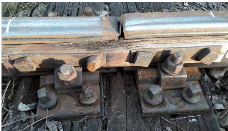
Imaginea nr. 5 Punctul a – joanta de vârf a inimii de încrucișare pe direcția abatere
