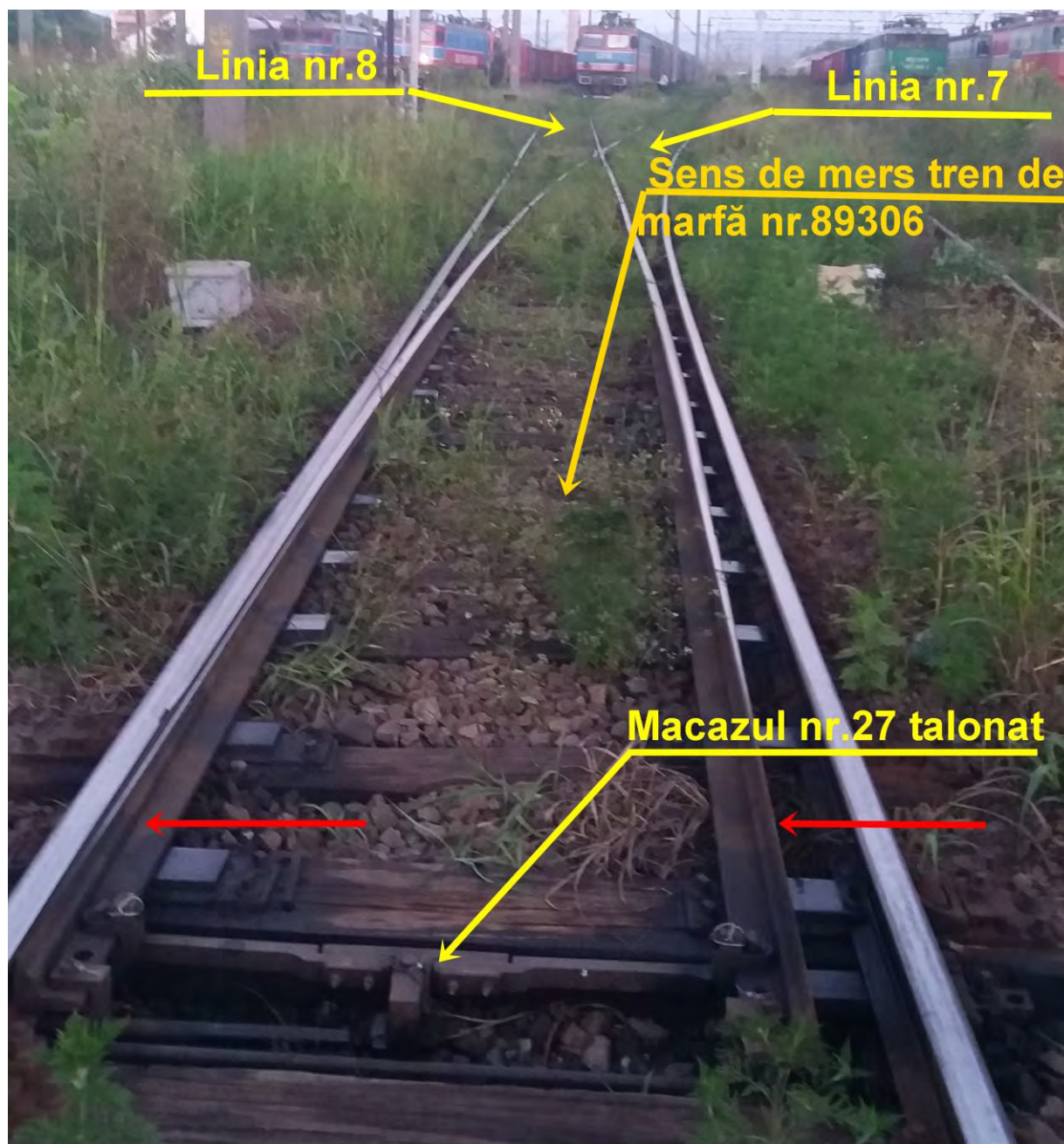
Fig.7 Macazul schimbătorului de cale nr.27 - talonat
