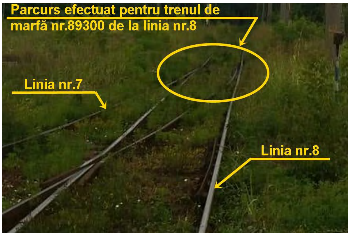
Fig.2 Poziția acelor macazului schimbătorului de cale nr.27
