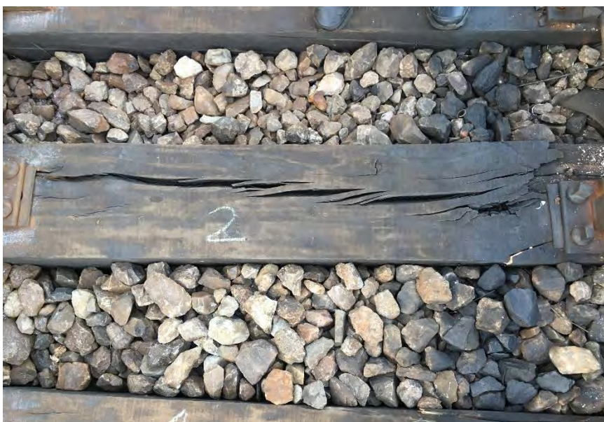
Traversa nr. „2”, firul interior al curbei – crăpătură longitudinală și ruptură transversală
