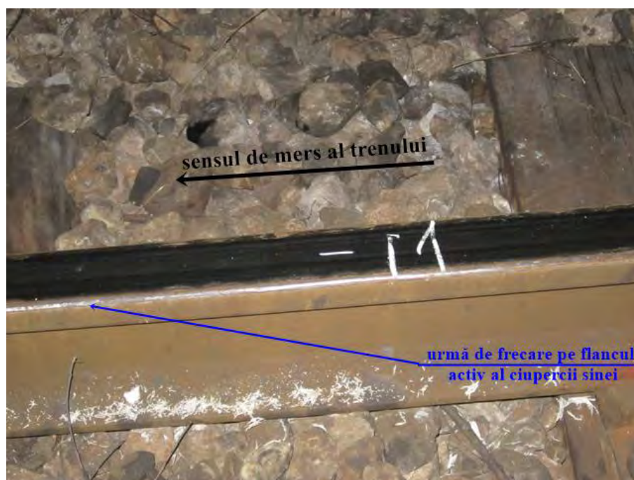
Șina de pe firul interior al curbei – pct.,-1”
