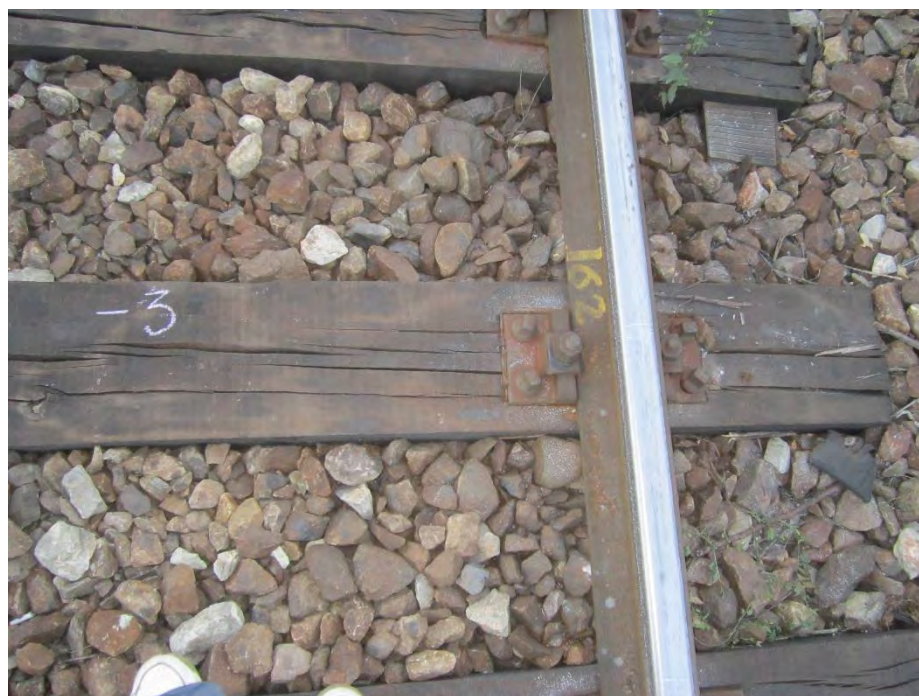
Traversa nr. „-3”, firul interior al curbei – crăpături longitudinale în zona prinderilor
