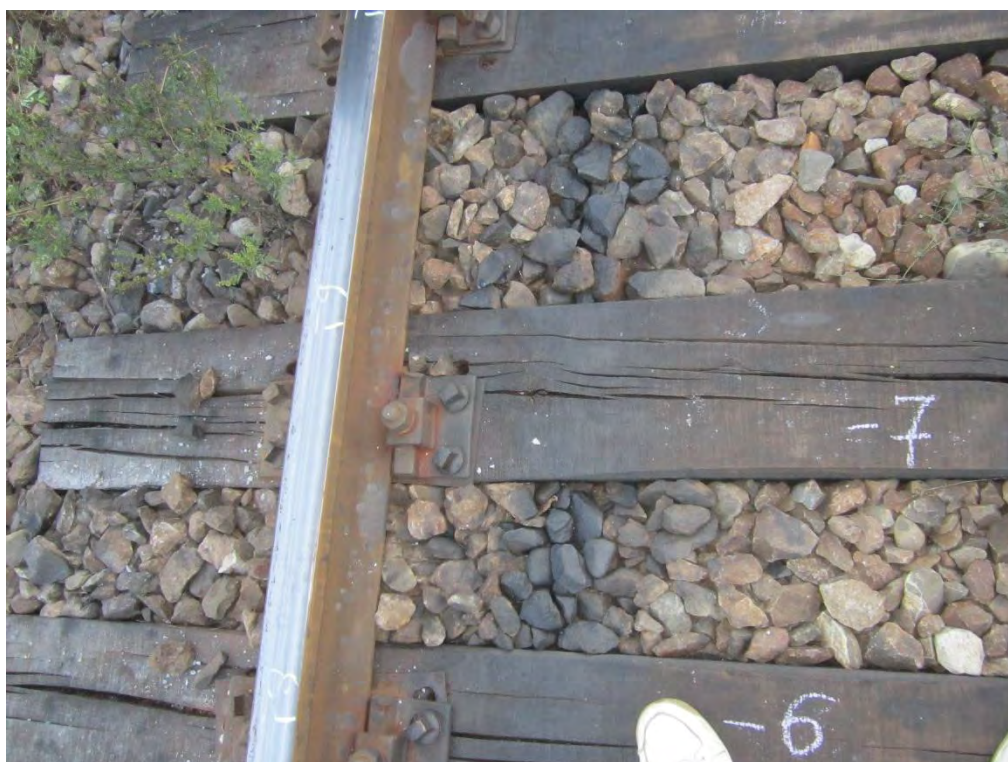
Traversa nr. „-6” și „-7”, firul exterior al curbei – crăpături longitudinale și găuri vechi rezultate prin scoaterea tirfoanelor (în care nu au fost introduși cepi)
