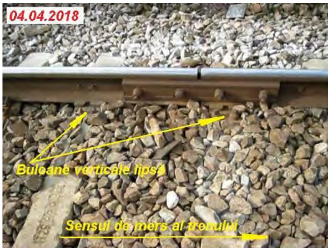
Foto nr.8 – Joanta de capăt a JIL-ului de la semnalul de trecere BL11, de pe firul din stâng al căii
