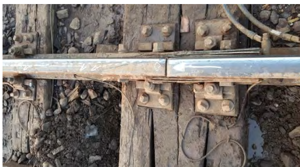
Foto nr.16 – prisma de piatră spartă colmatată(joantă noroioasă)
