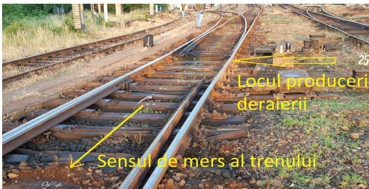
Foto nr.2 - parcursul trenului – schimbătorul nr.21A atacat pe la călcâi, schimbătorul nr.25A atacat pe la vârful, ambele pe direcția abatere
