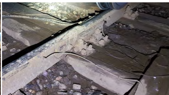
Foto nr.16 – prisma de piatră spartă colmatată(joantă noroioasă)
