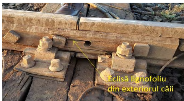
Foto nr.14 eclisa de lignofoliu din exteriorul căii
