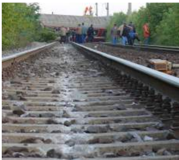
traversele distruse de buzele bandajelor roților din partea stângă ale locomotivei foto 17
