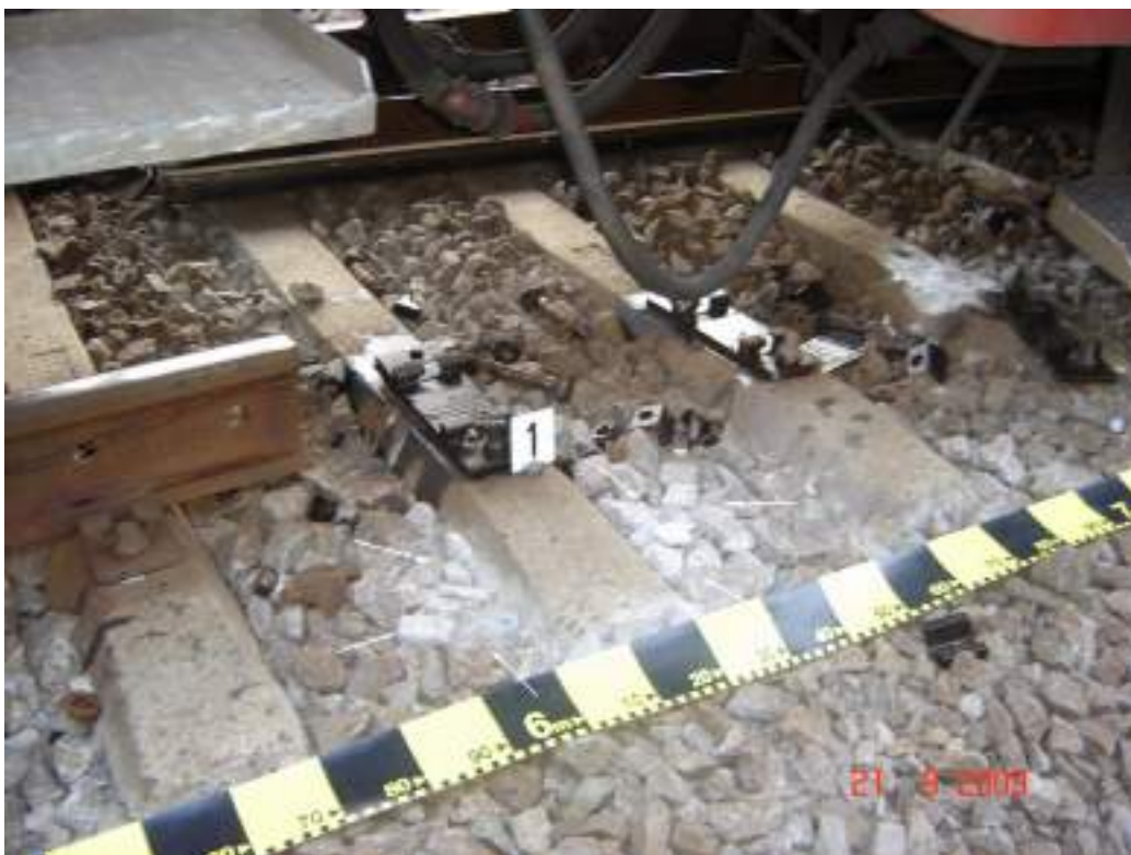
piatra spartă rotunjită și albicioasă din zona capătului foto27 din pareta dreaptă a primei traverse a panoului tampon
