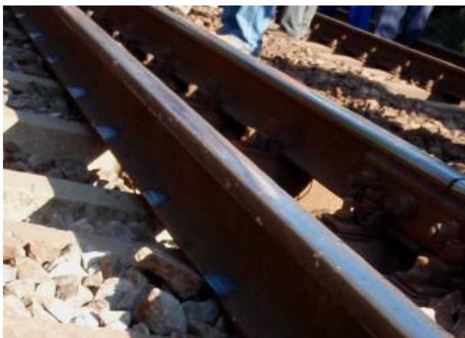
urme de material lubrefianț pe talpa șinei foto 2
