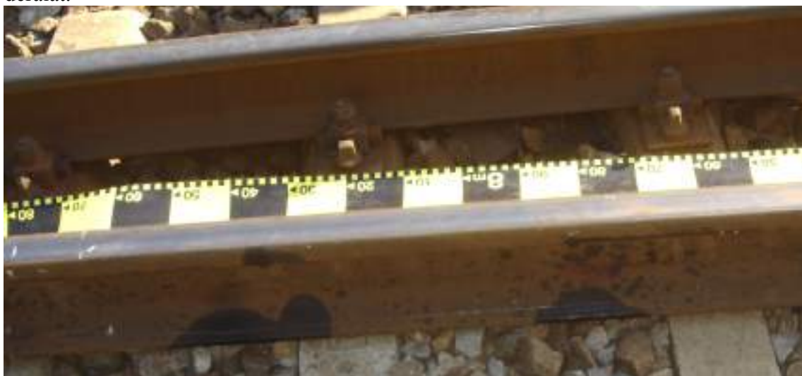
urmele lăsate de materialul rulant pe talpa șinei foto 4
