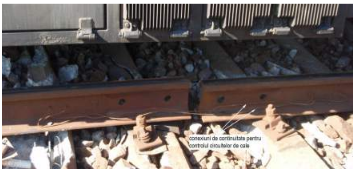
joanta din partea stângă a sensului de mers dintre panoul tampon și calea fără joante foto 10
