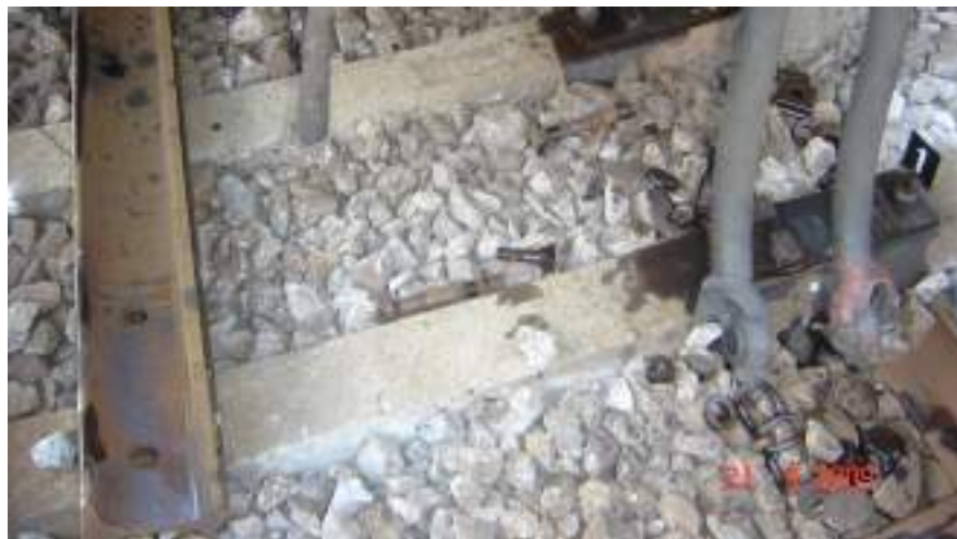
șina scoasă din rebordurile plăcilor metalice foto 29
