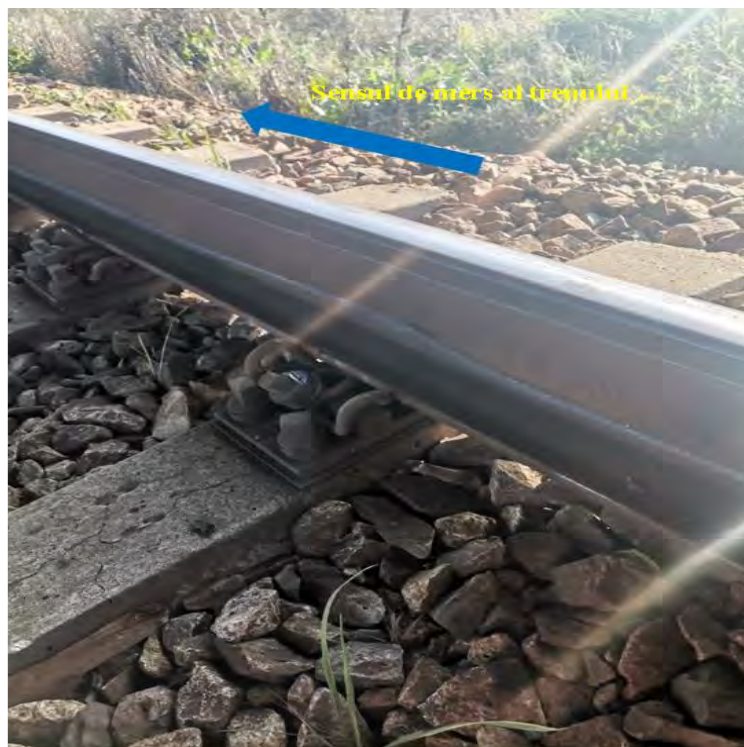
Foto nr.11 – urme de rulare pe talpa șinei și pe elementele de prindere
