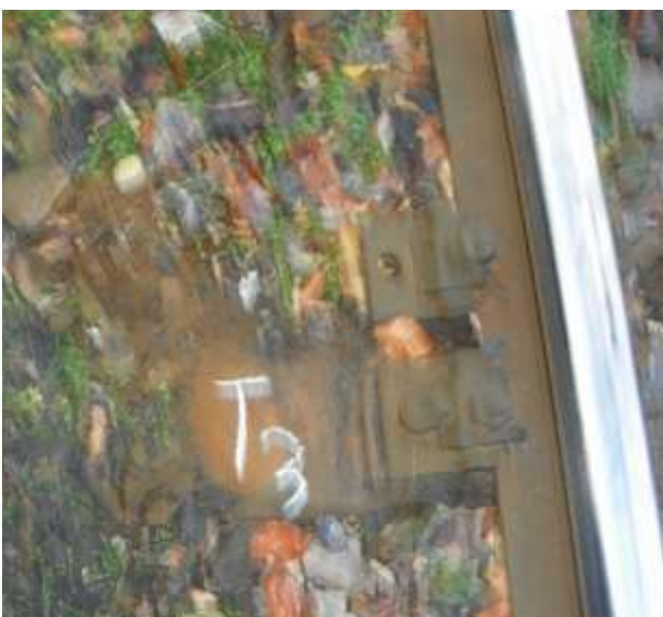
Foto.nr.14 - Traversa T 3
