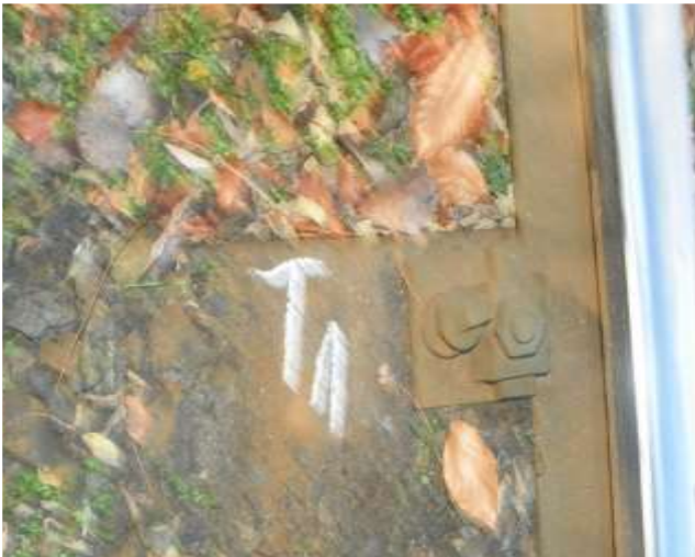
Foto.nr.12 - Traversa T 1
