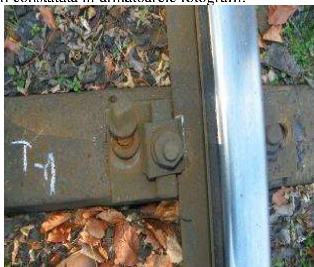
Foto.nr.9 - Traversa T 1
