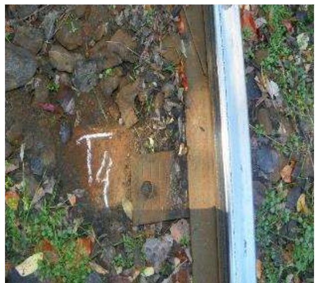
Foto.nr.15 - Traversa T 4
