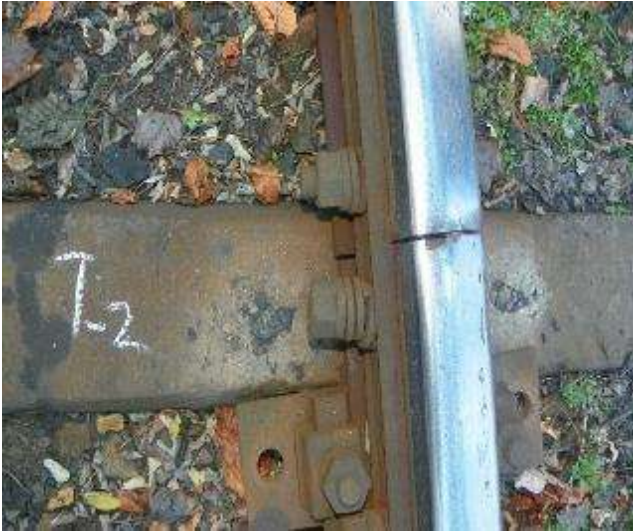
Foto.nr.10 - Traversa T 2
