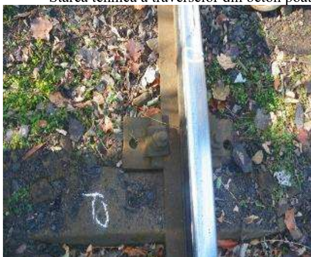
Foto.nr.8 - Traversa T 0
