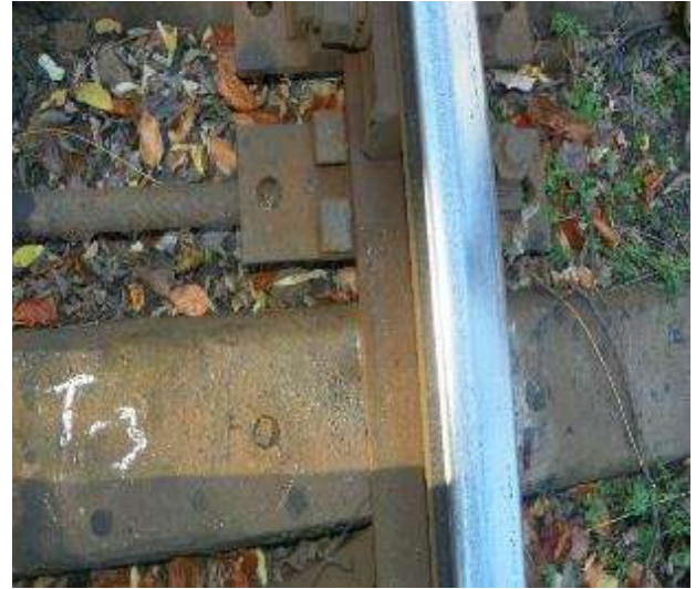
Foto.nr.11 - Traversa T 3
