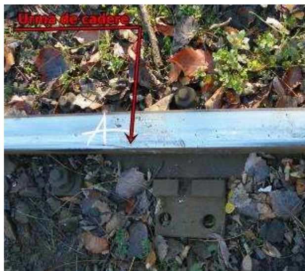
Foto nr.4: Punctul „A” – prima urmă de cădere în exteriorul căii (roata din partea dreaptă a osiei nr.6)
