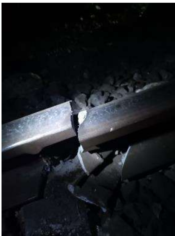
Foto nr. 11 Șina ruptă la linia 3 abătută pe firul stâng
