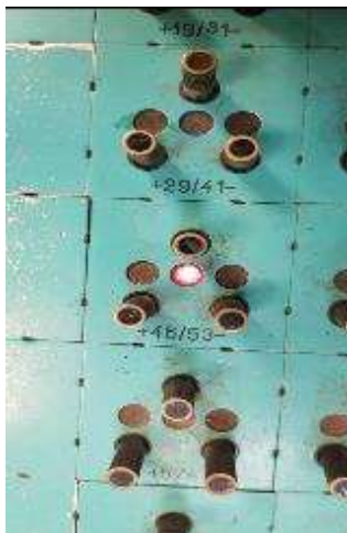
Foto nr.13 Macazul nr.45/53 fără control pe lumnoschemă
