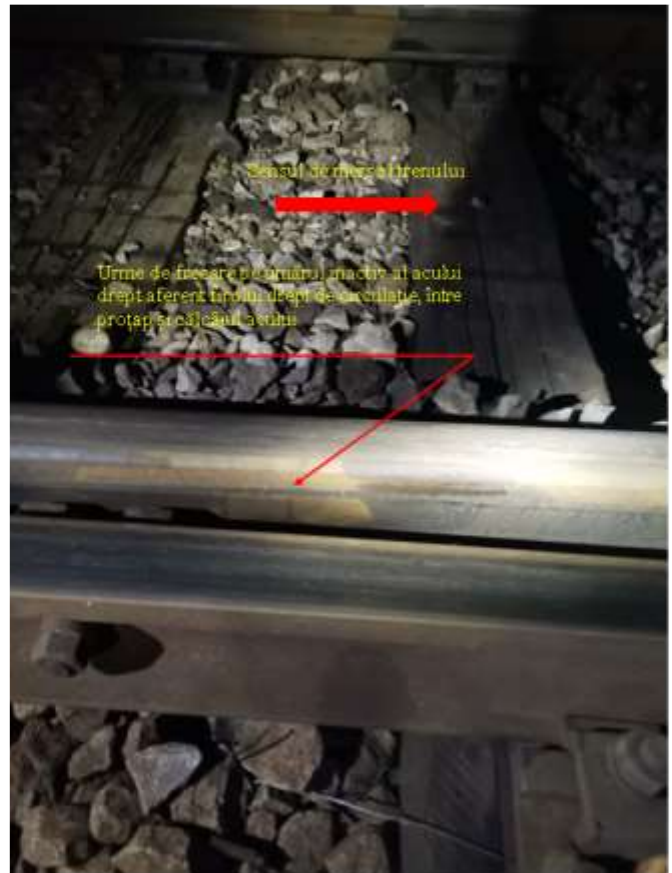
Foto nr. 7 Urme de frecare pe umărul inactiv al acului drept între proțapi și călcâiul acului
