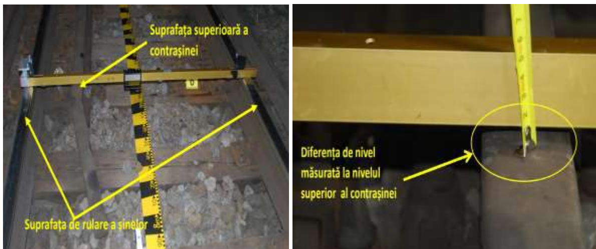
Foto nr.25, 26 - Nivelul superior al contrașinei sub nivelul suprafeței de rulare a șinelor.
