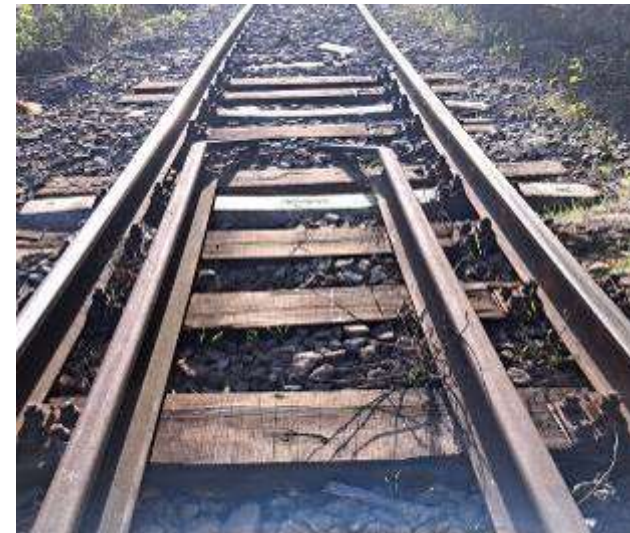
Foto nr.31 – lipsă prindere pe fiecare traversă
