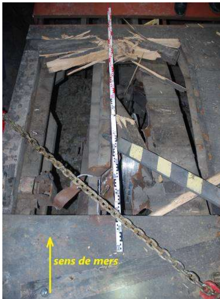
Foto nr.5 – porțiunea din podeaua de lemn lipsă
