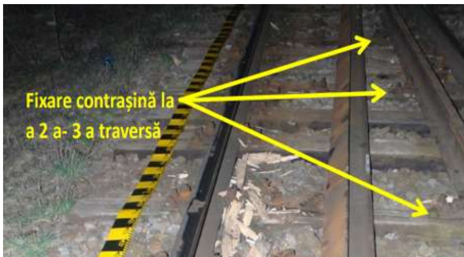
Foto nr.21 - Contrășină fixată numai la fiecare a doua – treia traversă
