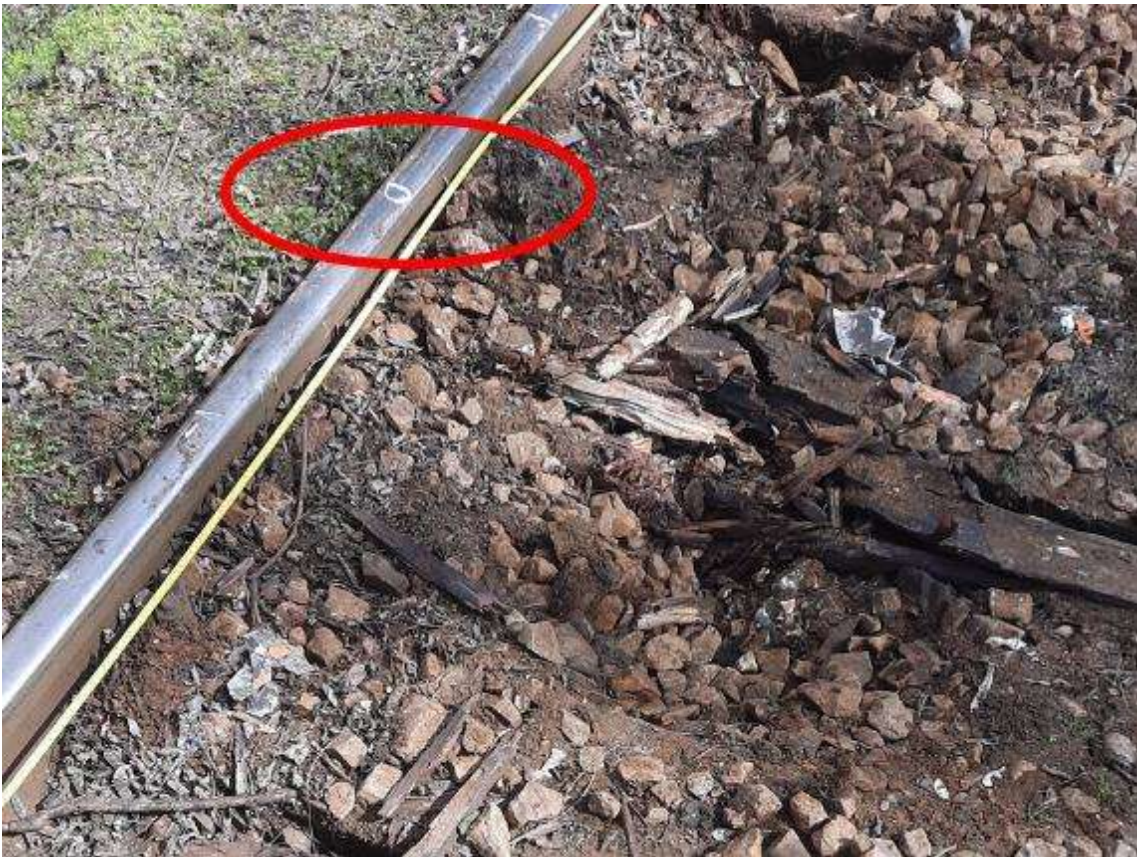
Foto nr.1: Prima urmă de deraiere la km. 20+030 punct „0” (firul din stânga).
