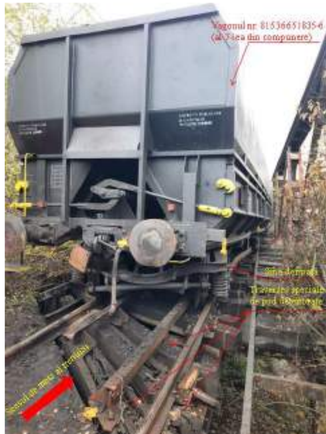
Foto nr.15: Starea traverselor pe pod în urma deraierei
