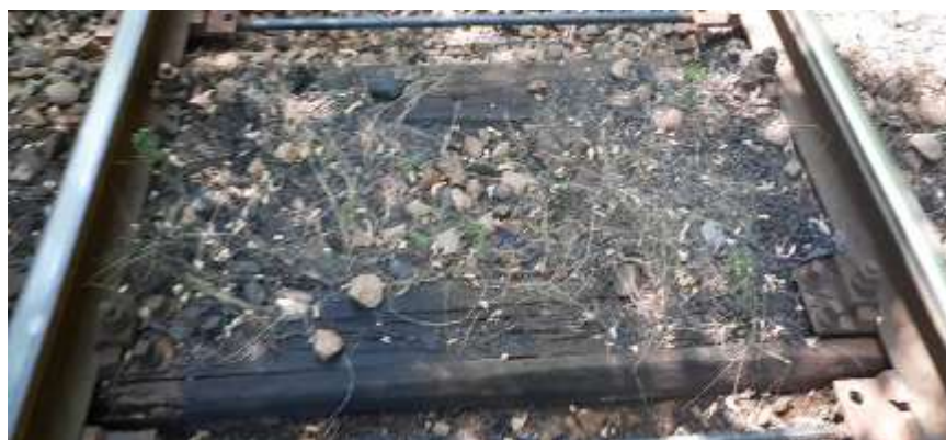
Imaginea nr.11 (la 16.07.2024) – traverse și tiranți pe curba pe care s-a produs accidentul feroviar
