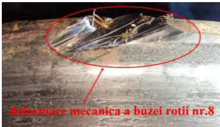
Foto nr.2 Buză roții nr.8 deteriorată
