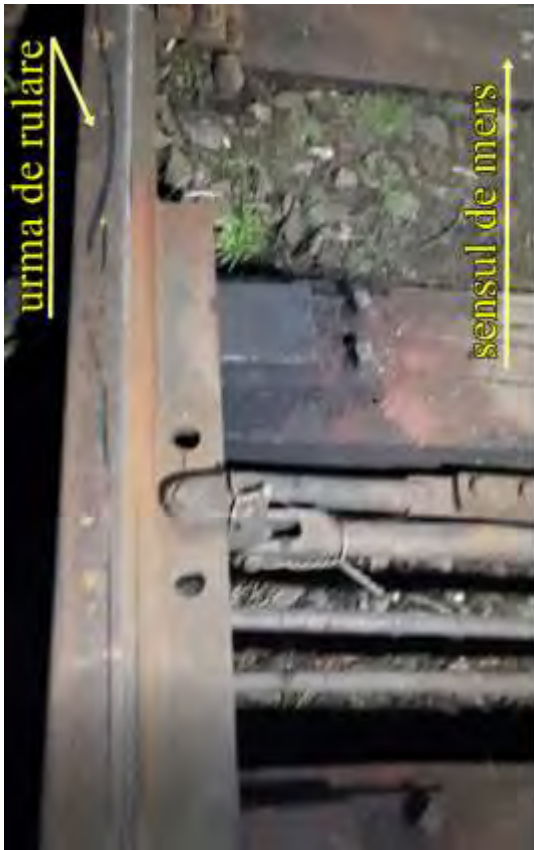
Foto. nr.16 – urma pe suprafața de rulare a contraacului drept și pe șina de rulare a contrașinei schimbătorului nr.21a
