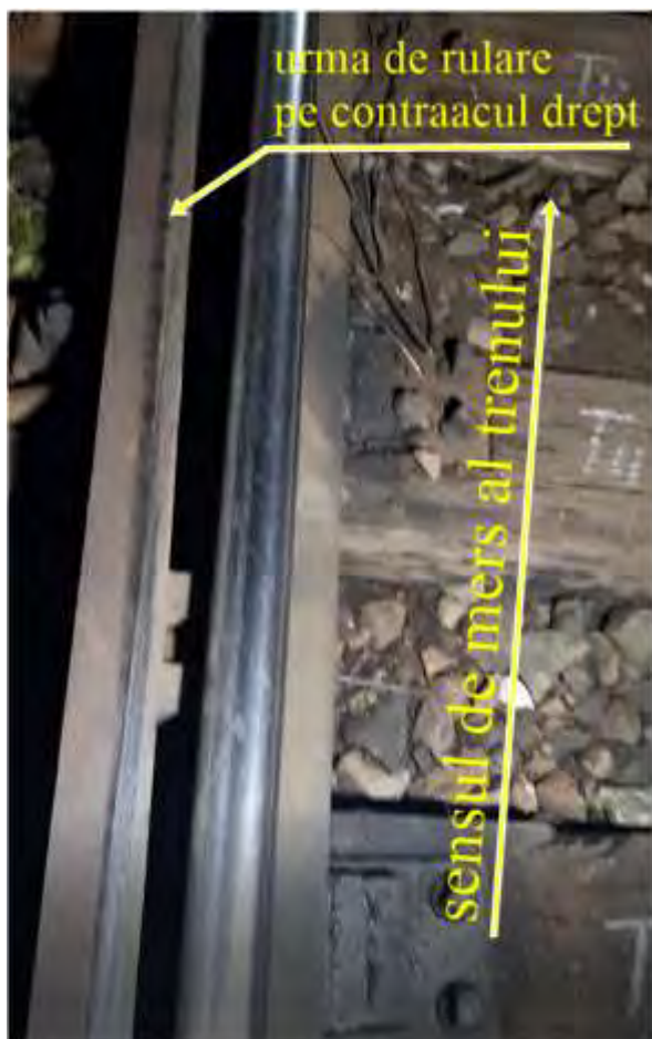
Foto. nr.13 – urma de rulare pe contraacul drept al schimbătorului nr.27a
