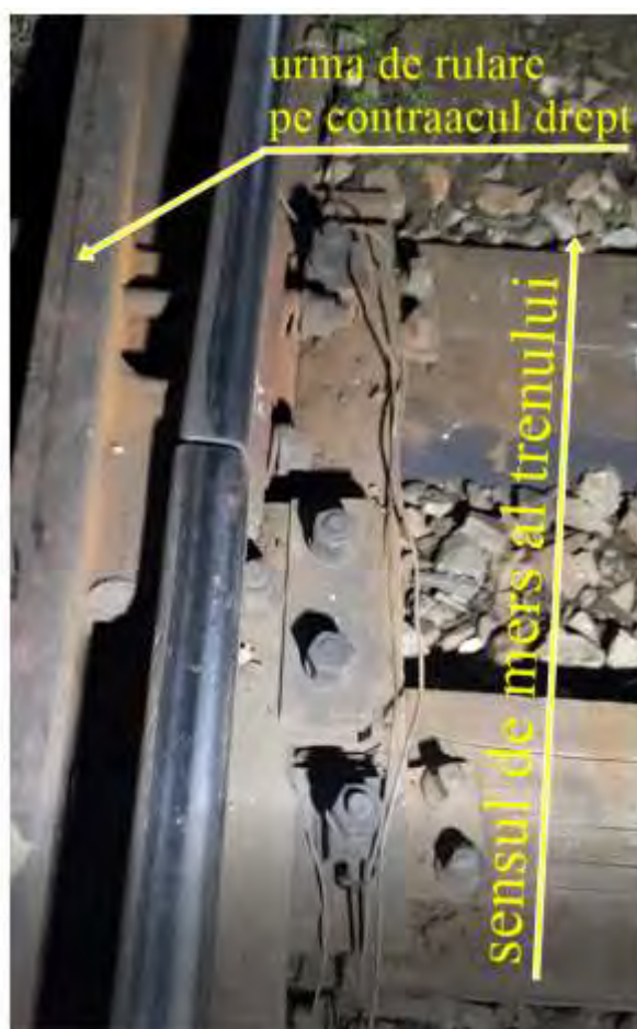
Foto. nr.13 – urma de rulare pe contraacul drept al schimbătorului nr.27a
