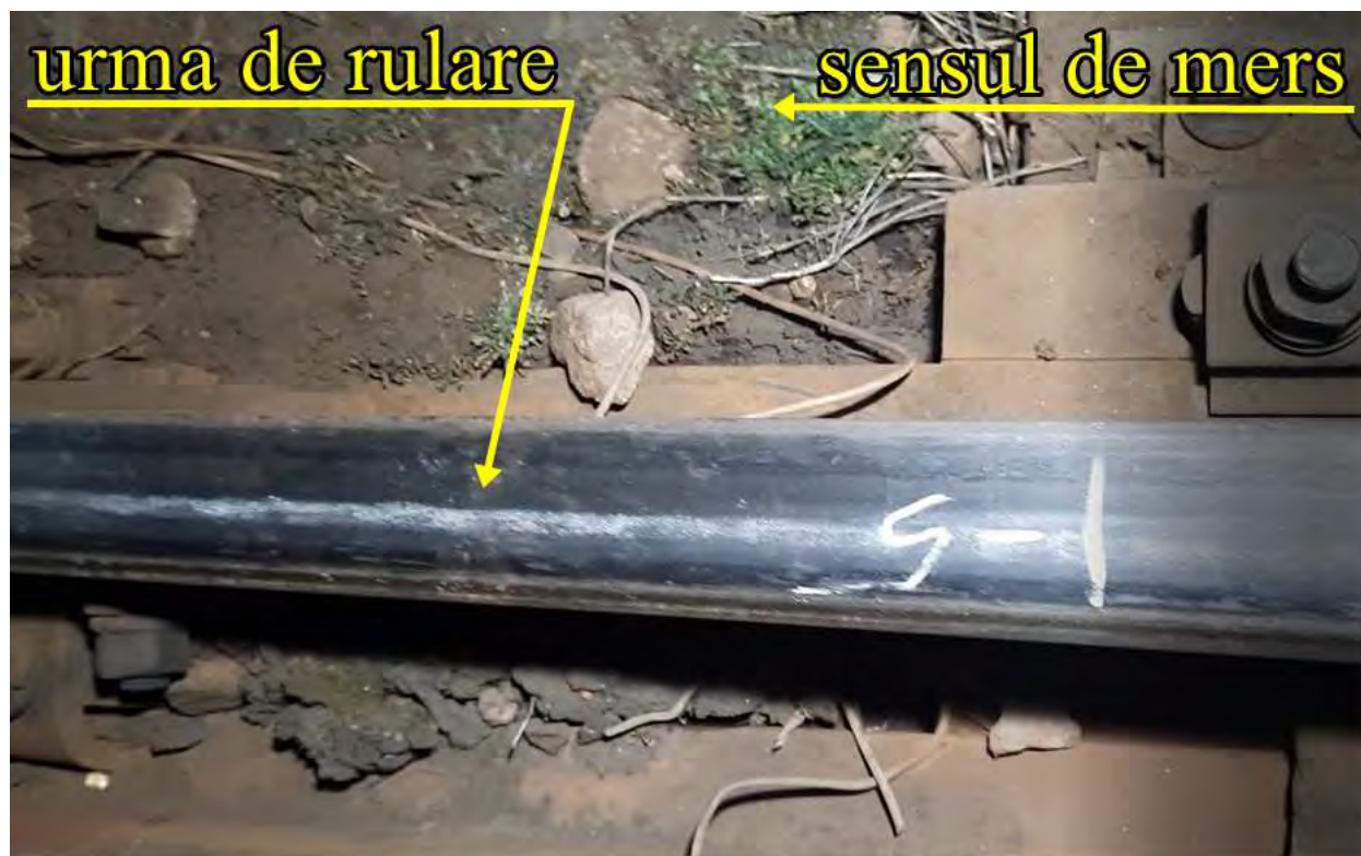
Foto. nr.25 – urma de rulare pe contraacul curb a schimbătorului nr.27a
