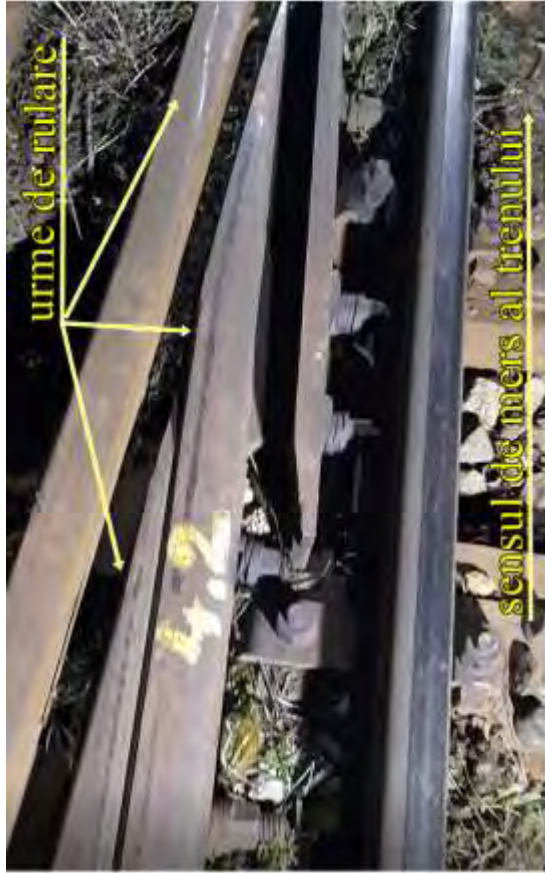
Foto. nr.14 – urma de rulare pe suprafața de rulare a inimii duble și pe a șinei cot
