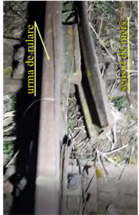
Foto. nr.16 – urma pe suprafața de rulare a contraacului drept și pe șina de rulare a contrașinei schimbătorului nr.21a
