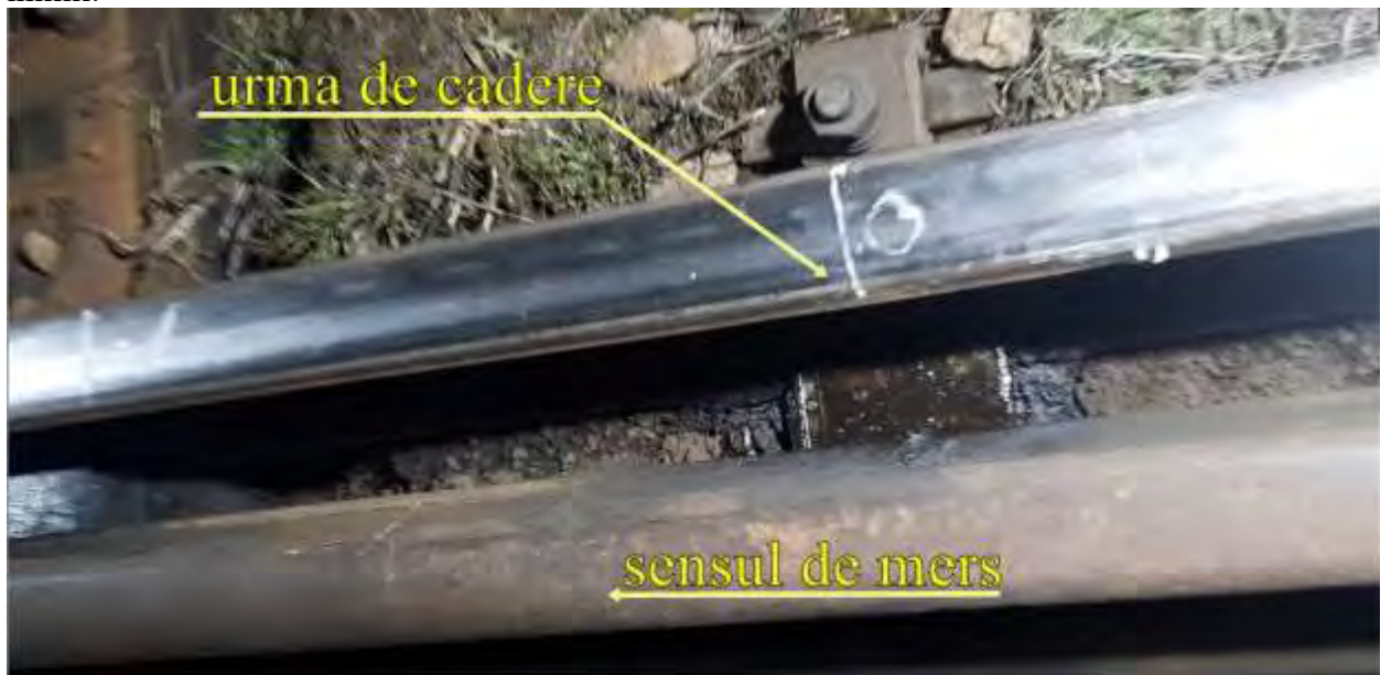
Foto. nr.17 – urma de cădere de pe contraacul curb între ac și contraac
