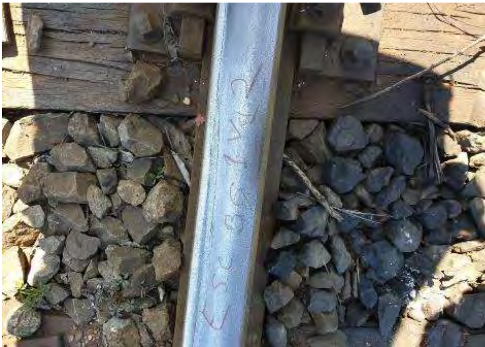
Foto nr.7 - Locul unde a escaladat boghiul nr.1 al vagonului nr.33537965097-1
