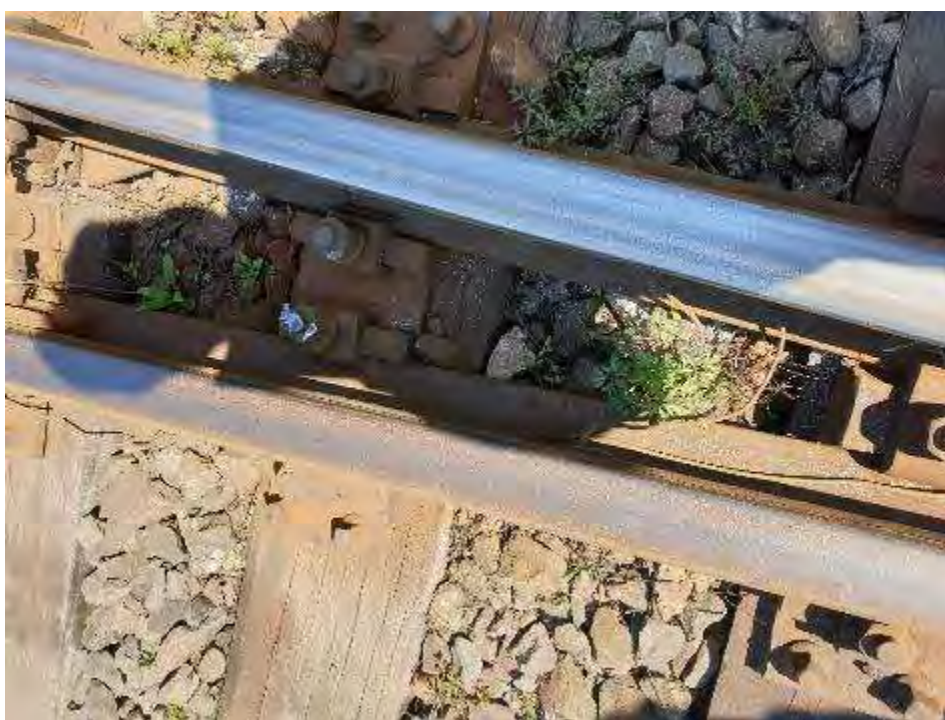
Foto nr.9 - Locul unde boghiul nr.2 al vagonului nr.33537965097-1 a lovit primul bulon
