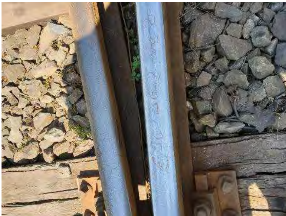
Foto nr.8 - Locul unde a escaladat boghiul nr.2 al vagonului nr.33537965097-1
