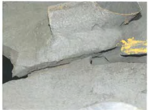
Foto nr. 6. -aspect probă după îndepărtarea suporturilor (stânga) și detaliu crăpătură dreapta
