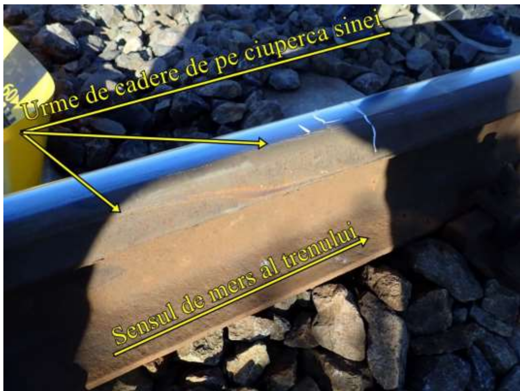
Foto nr.3 - urmele de cădere de pe ciuperca șinei firului exterior al curbei
