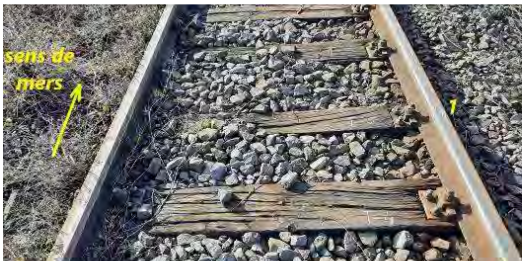
Foto nr.2 - punctul „1” - punctul de escaladare de către roata din partea dreaptă
