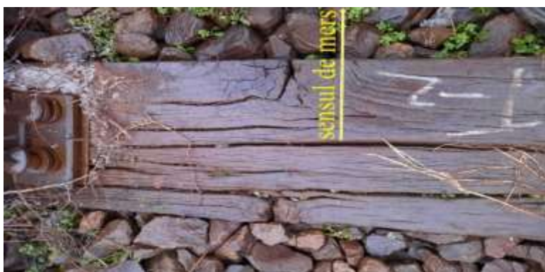
Foto. nr.6 - Traversa nr.T-2
