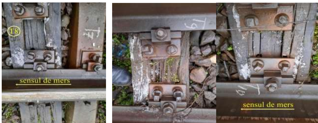
Foto. nr.9 - Traversele T8, T9 și T10
