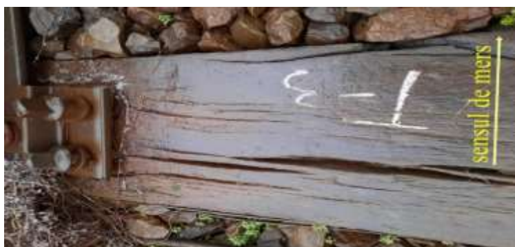
Foto. nr.7 - Traversa nr.T-3
