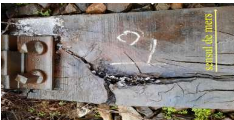
Foto. nr.4 - Traversa nr.T0
