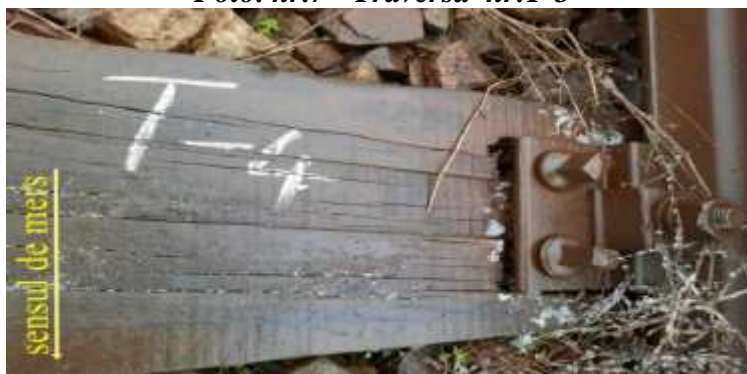
Foto. nr.5 - Traversa nr.T-4
