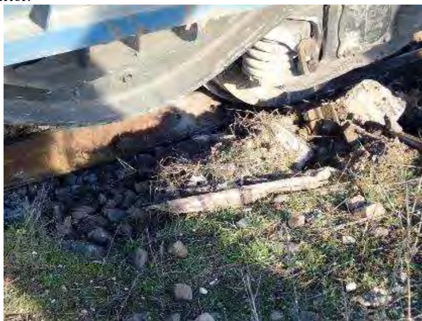
Foto nr.4 - vagoanele deraiate și șina deplasată/înclinată sub vagoane
