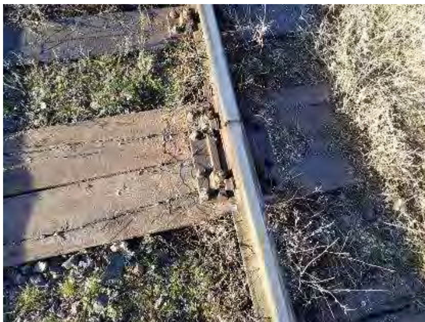
Foto nr.2 - punctul „0” - prima urmă de deraiere
