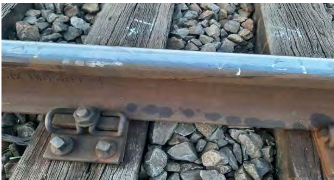
Foto. nr.13 – Punctul „A”: prima urmă de cădere de pe flancul inactiv al ciupercii șinei
