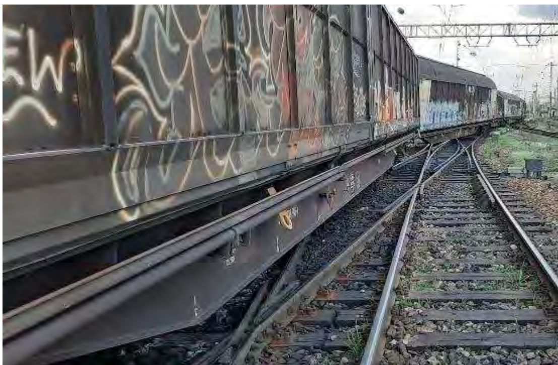
Foto nr.2 – vagoanele deraiate în zona bretelei 15/21-17-25/31-29
