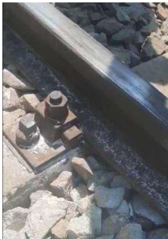
Foto nr.12, urmă de rulare a buzei bandajului pe firul exterior (firul din stânga în sensul de mers al trenului) respectiv pe firul interior
