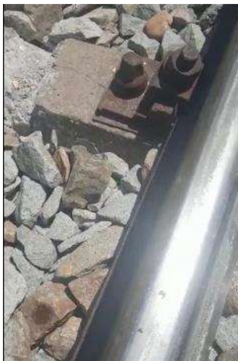
Foto nr.14, capătul traversei din dreptul punctului „0”
