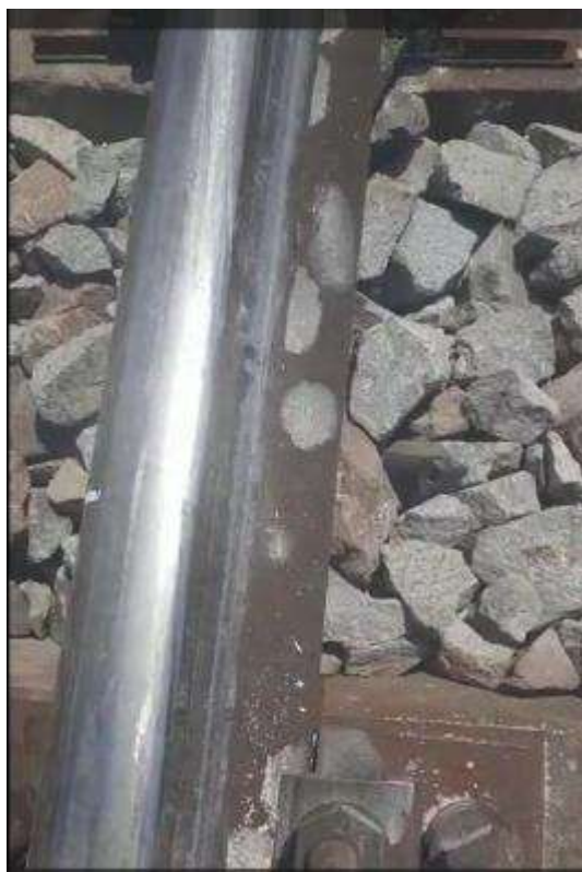
Foto nr.12, urmă de rulare a buzei bandajului pe firul exterior (firul din stânga în sensul de mers al trenului) respectiv pe firul interior
