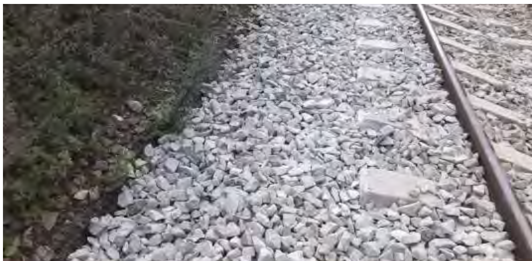
Imaginea nr.12 – strat de geotextil și geogril pe porțiunea cu restricție de viteză
