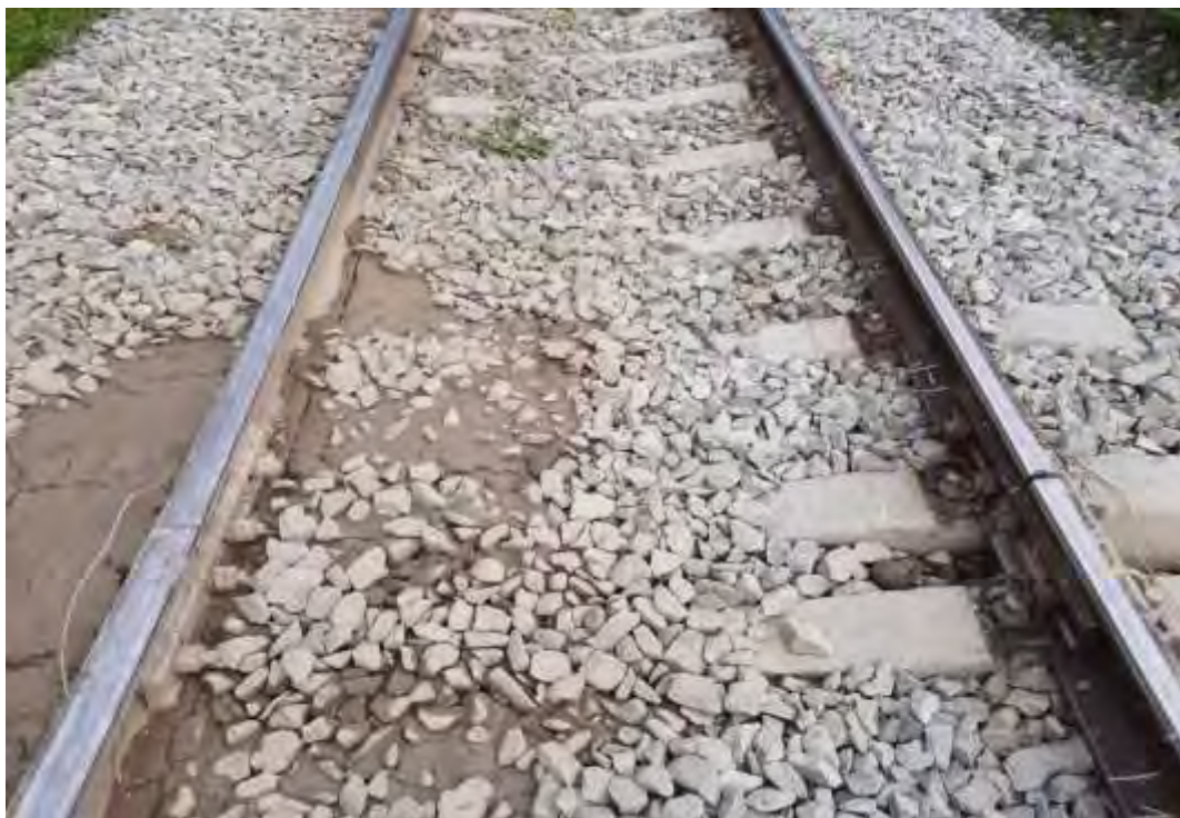
Imaginea nr.9 – prisma de piatră spartă în zona punctului „0”
