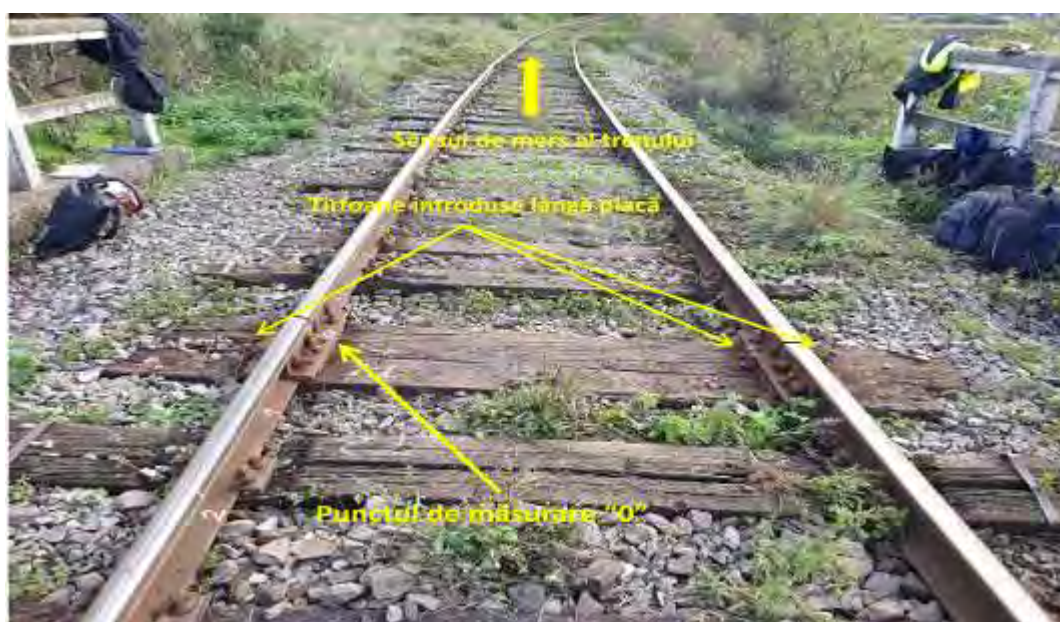
Foto.nr.10 - traversele T_0 , T_1 și punctul de măsurare „0” marcat pe șina firului exterior
