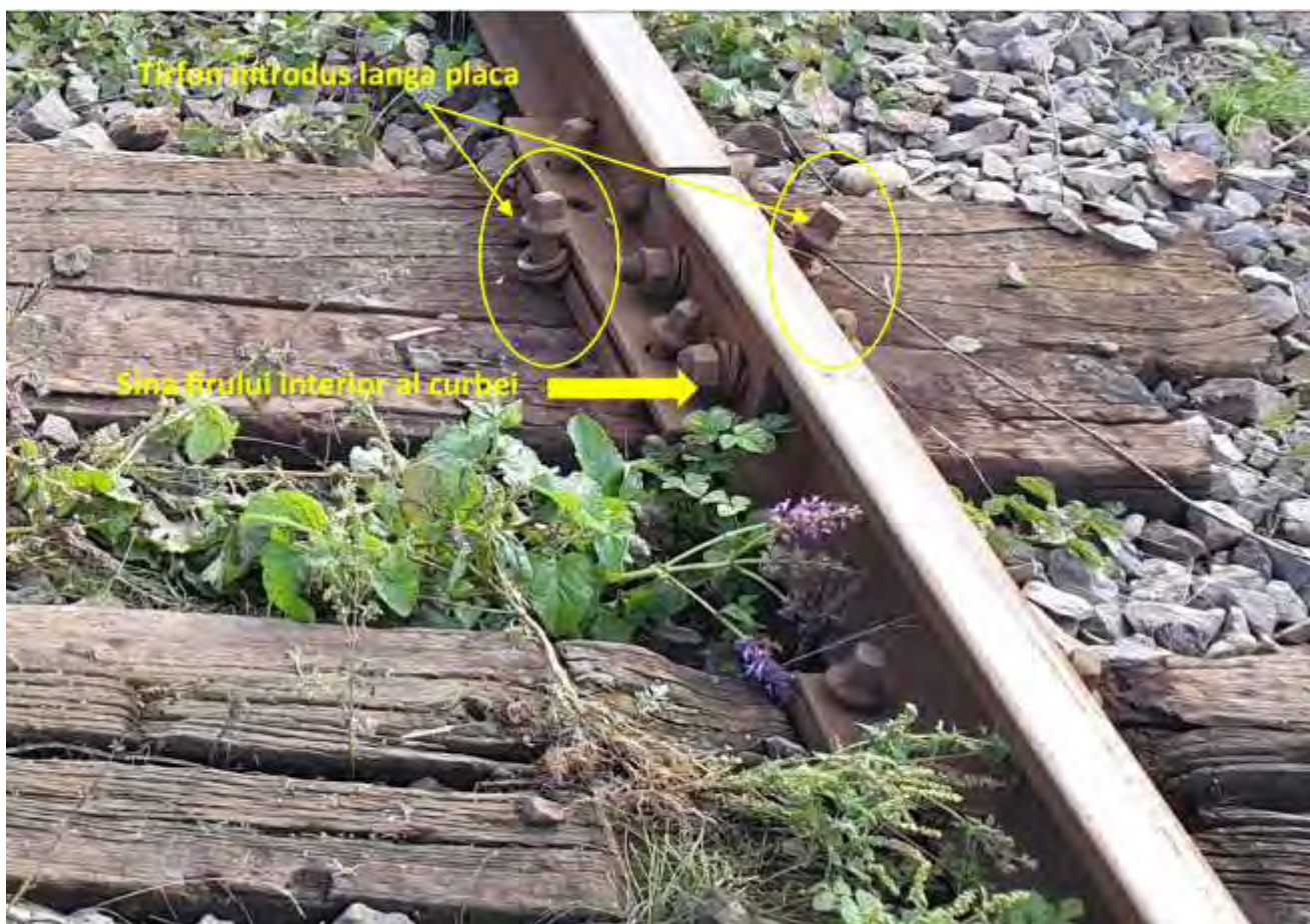
Foto.nr.12 - șina firului interior - tirfoane introduse lângă placă în vederea consolidării prinderii)
