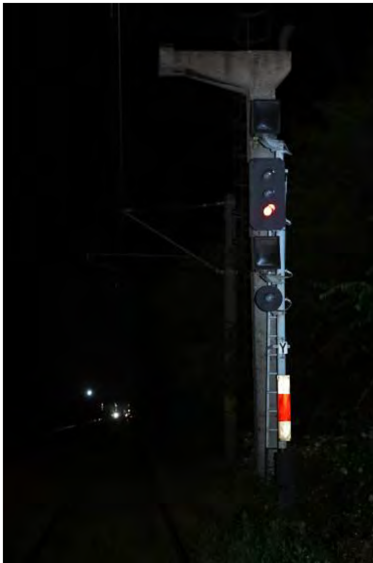
Foto nr.1 - Poziția și indicația semnalului de intrare Y al stației CFR Craiova - „OPREȘTE fără a depăși semnalul ! Ziua și noaptea - o unitate luminoasă de culoare roșie, spre tren“
