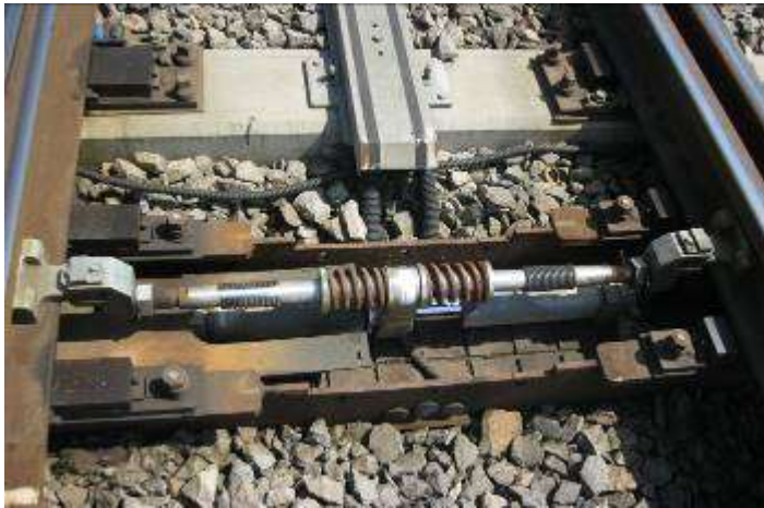
Foto nr.4 – a treia înzăvorâre fără capacul de protecție
