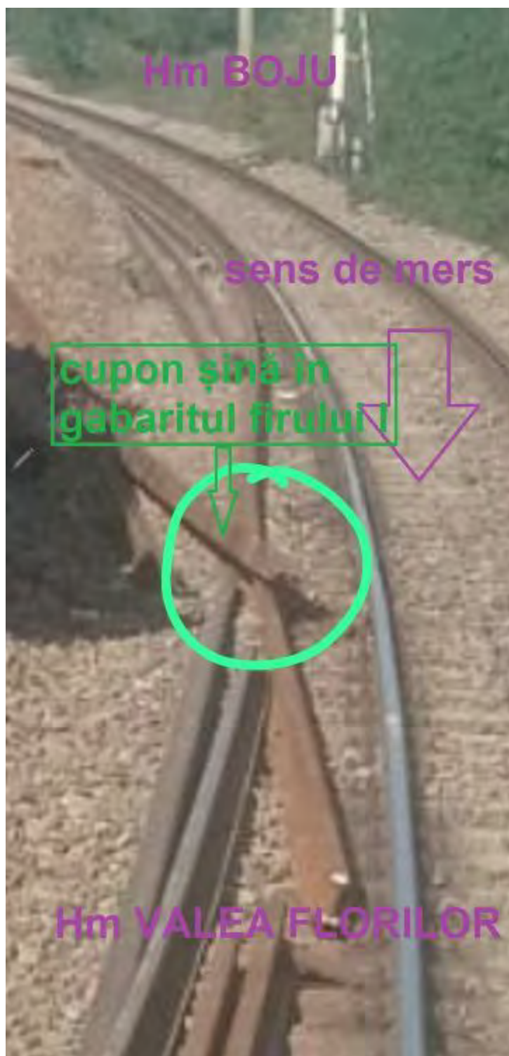
Figura nr.6 – Imagine cu șina care a produs incidentul-foto după producerea incidentului
