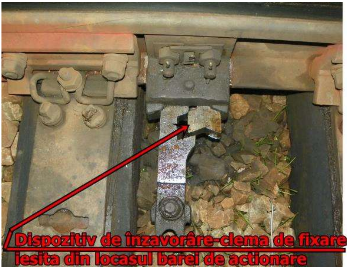
Foto nr.5 Dispozitiv de înzăvorâre macaz schimbător de cale nr.14
