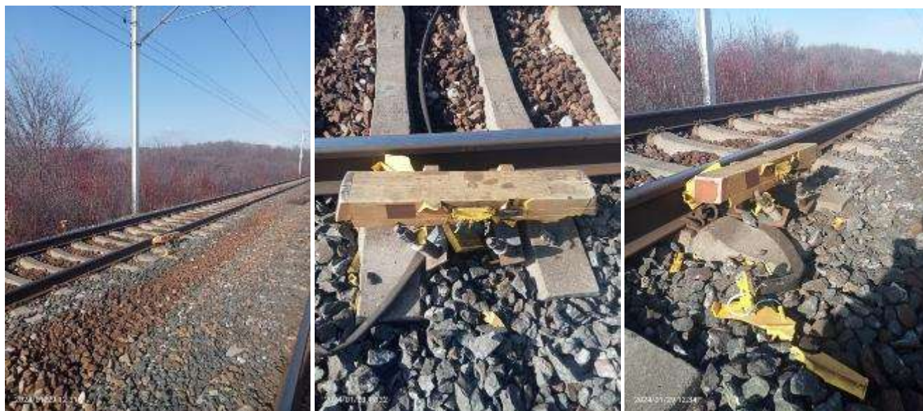
Foto. 3: Inductorul de 500Hz aferent semnalului BI21 lovit
