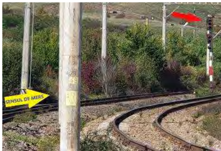
Imaginea nr.2- semnalul repetitor RX1 al semnalului luminos de ieșire X1, avea indicația Semnalul următor este „pe oprire”
