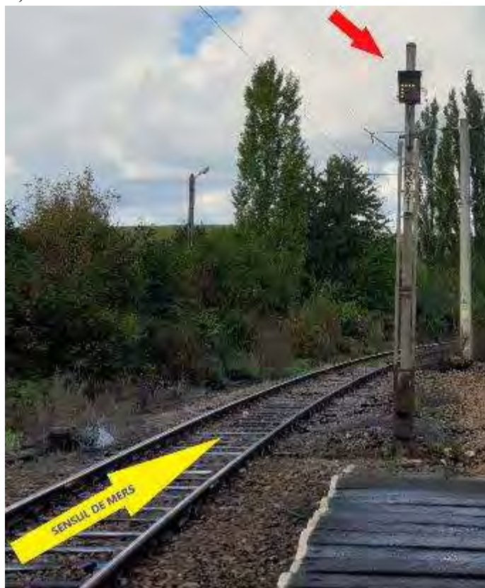
Imaginea nr.2- semnalul repetitor RX1 al semnalului luminos de ieșire X1, avea indicația Semnalul următor este „pe oprire”
