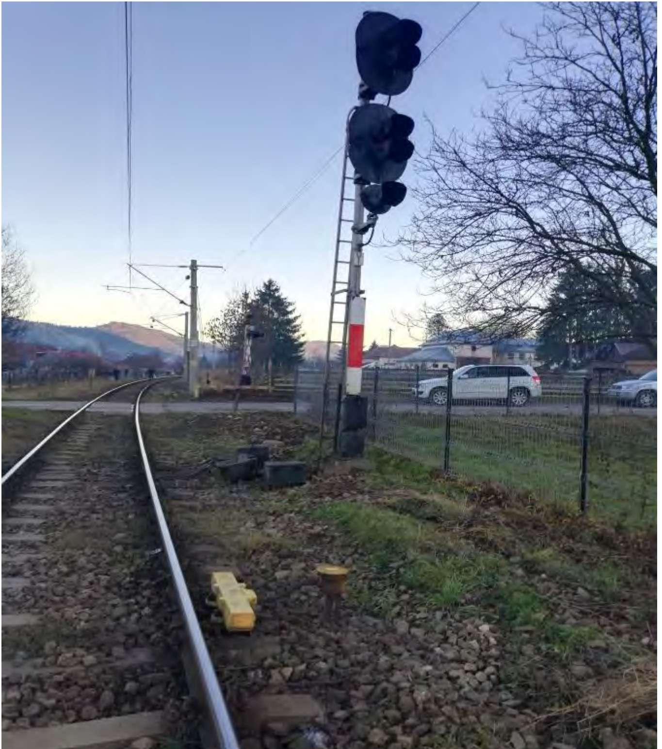
Foto nr.3– Pasajul de trecere la nivel cu calea ferată, situat la km.71+150, imediat după semnalul de intrare Y al stației CFR Câmpulung Moldovenesc
